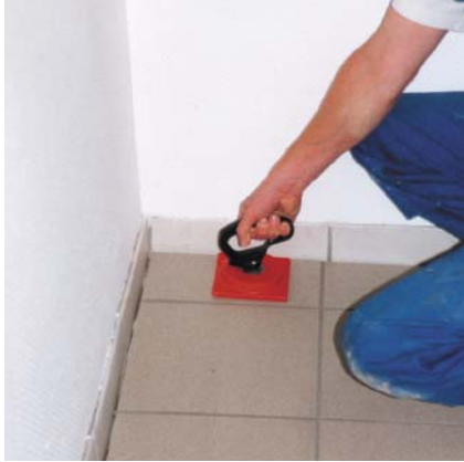
Anheben der Belagebene mittels Saugnapf
