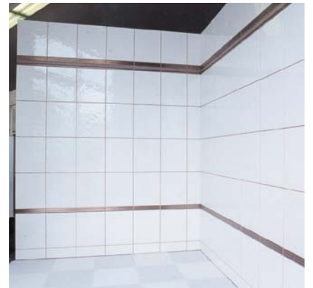
Wandflächen verlegt mit neuem Belag; MAPETEX im Bodenbereich aufgebracht
