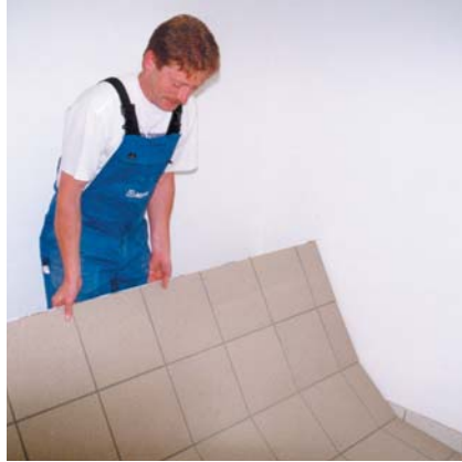
Aufknicken/umklappen des auf MAPETEX verlegten Belages
