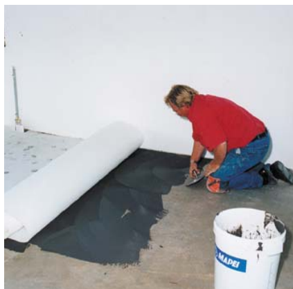
MAPETEX zur Entkopplung eines Keramikbelages auf jungem Beton
