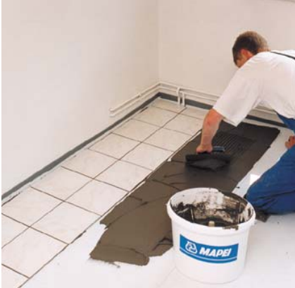
Verlegen der keramischen Fliesen mit KERAQUICK
