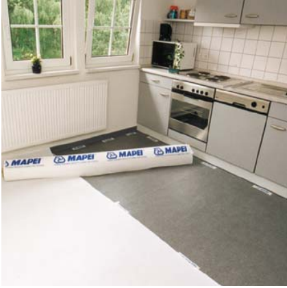
Fixieren von MAPETEX auf MAPETEX-STRIP
