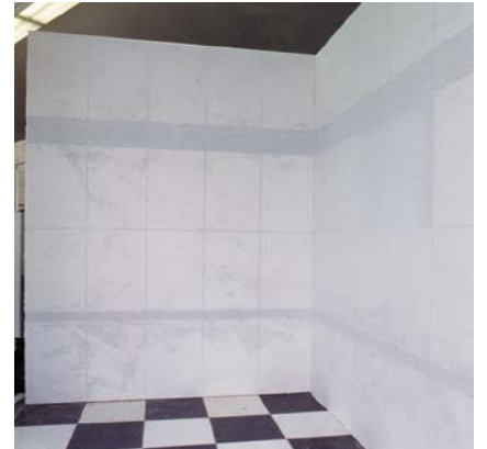
Fixieren von MAPETEX auf MAPETEX-STRIP im Wandbereich
