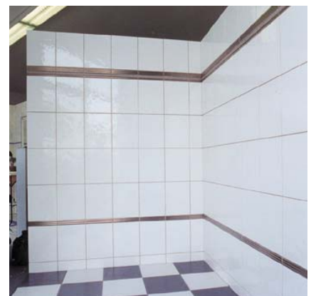
Mit KERAQUICK verlegte Bodenfliesen
