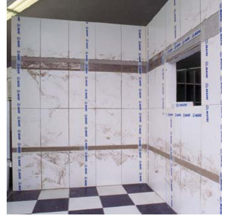
Erneuerung einer Ausstellungskoje; Verlegung von MAPETEX-STRIP
