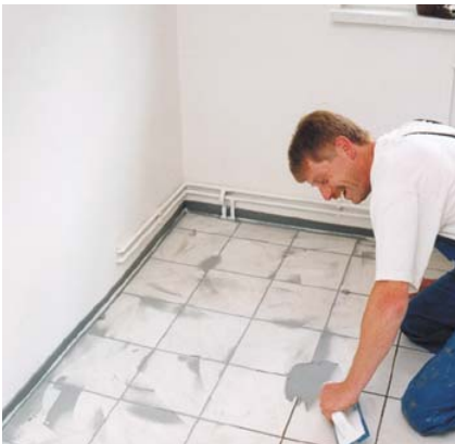
Verfugen des Belages mit MAPEI-Fugenmörtel
