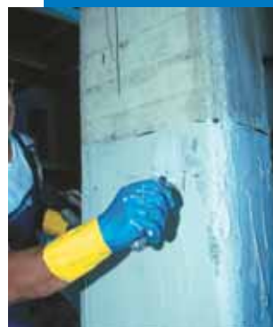
Ratissage éventuel avec Mapewrap 11 ou Mapewrap 12
