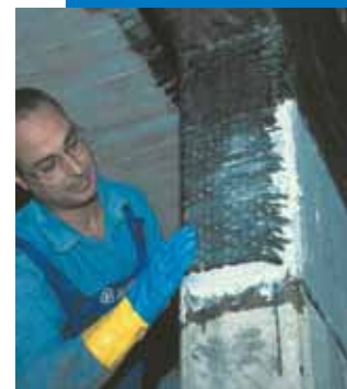
Renforcement d'un poteau et d'une poutre
