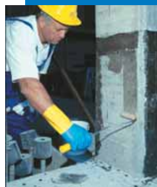
Application de Mapewrap Primer 1
