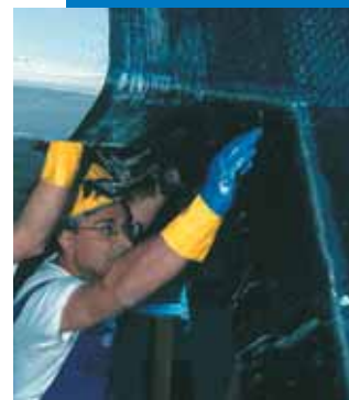
Renforcement d'un nœud poteau/poutre
