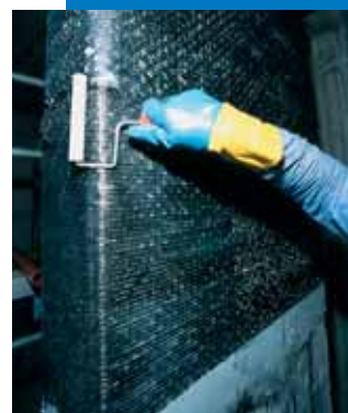
Application de la seconde passe de Mapewrap 31
