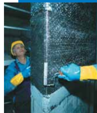
Marouflage de Mapewrap C BI-AX dans Mapewrap 31
