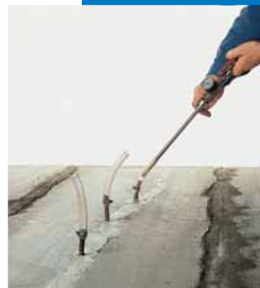
Rénovation par injection des structures horizontales
