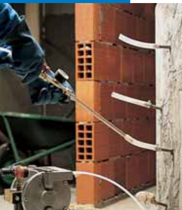
Injection d'Epojet dans un pilier fissuré
