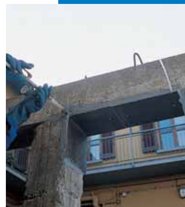
Injection d'Epojet dans des poutres renforcées avec des plaques métalliques
