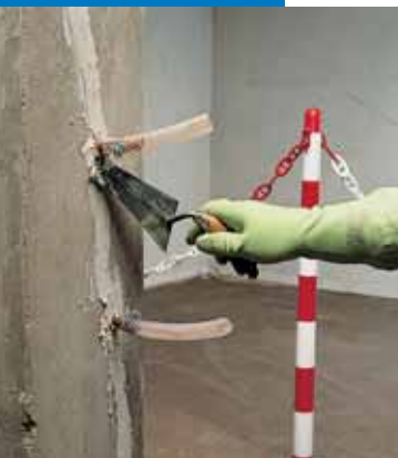
Fixation des injections avec Adesilex PG1
