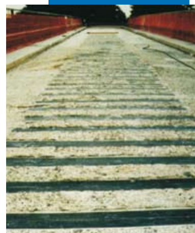
Travée béton renforcée avec les plats Carboplate
