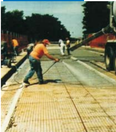
Application du primaire Epoxy
