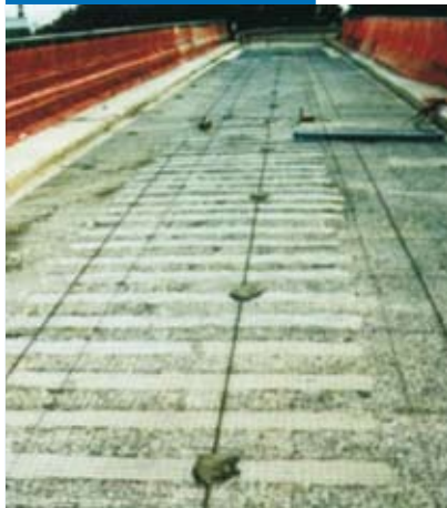
Reconstitution de la surface béton avec Mapegrout BM.
