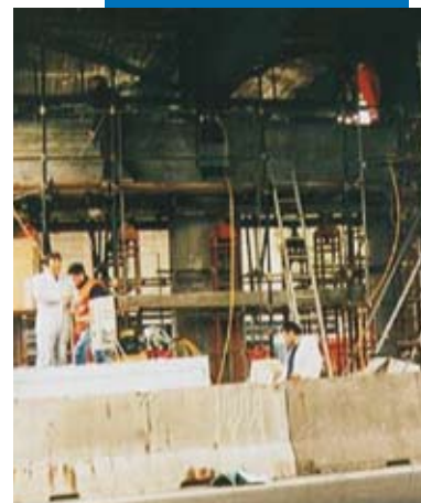
Vue du pont durant les opérations de renforcement
