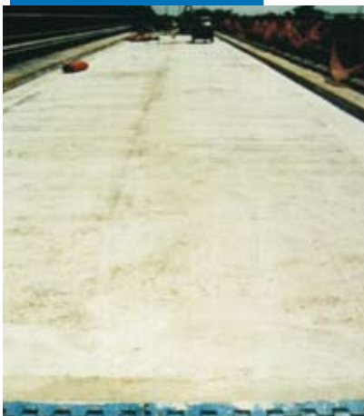
Travée béton reconstituée
