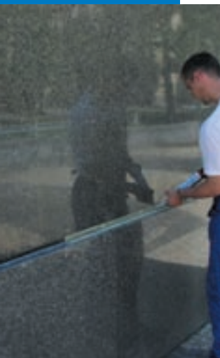
Joint de fractionnement en façade réalisé avec Mapesil LM.
