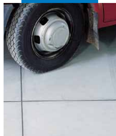
Joint de fractionnement de sol industriel en béton avec Mapeflex PU21
