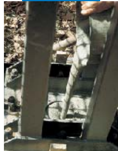
Scellement avec Mapefill
