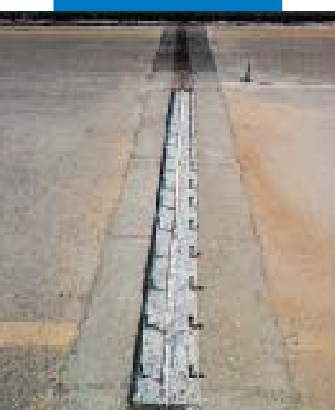
Rénovation de joint de pont d'autoroute avec Mapefill
