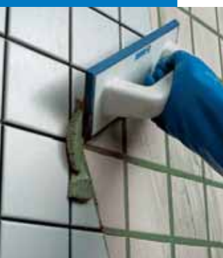
Jointoiment en mur avec la spatule caoutchouc
