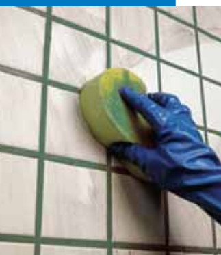
Nettoyage et finition des joints à l'éponge, en mur
